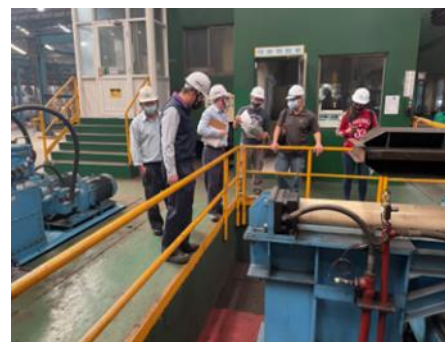
地上儲槽設備巡查
