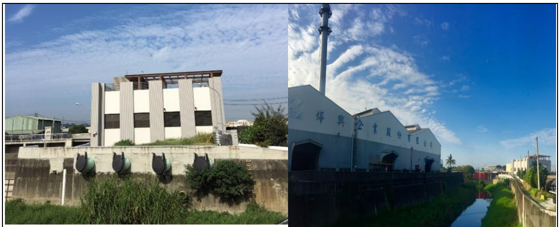
水利局抽水站
